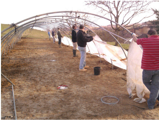
Montage de la nouvelle serre
